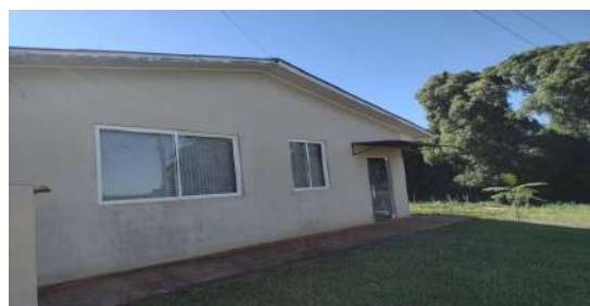
Figura 2. Área interna e corredor
