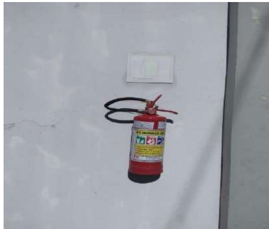
Figura 18. Prédio H (Fundos)
