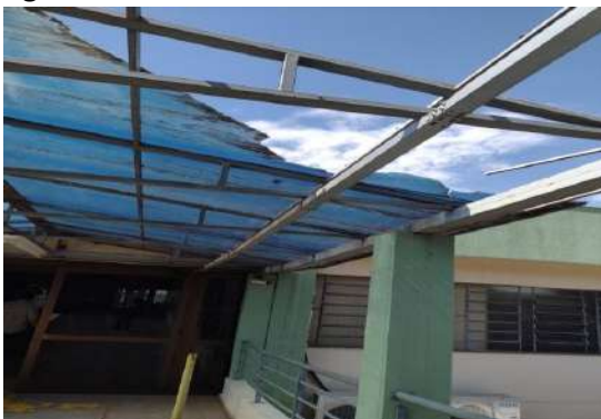
Figura 4. Passarela entre os Prédios
