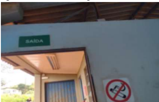
Figura 19. Prédio ADM Agrárias Sala Técnica
