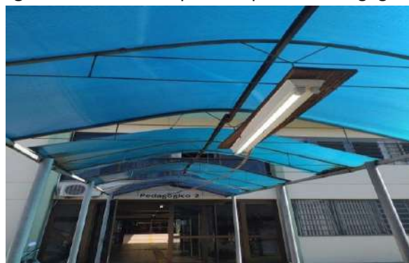
Figura 5. Passarela para o prédio Pedagógico 2
