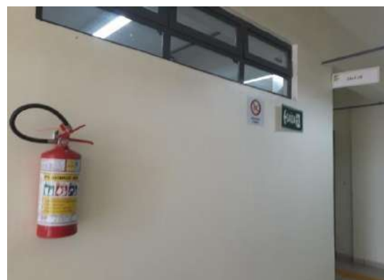
Figura 14. Prédio H (próximo à sala H8)
