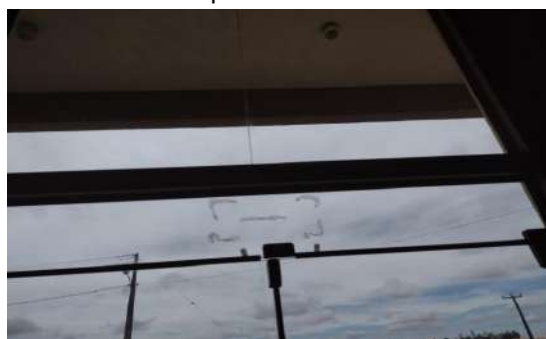
Figura 33. Ginásio Sinalizações de Saídas - Portas que abrem sentido evasão
