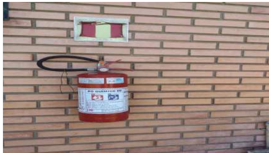
Figura 12. Prédio E – Cantina-fundos
