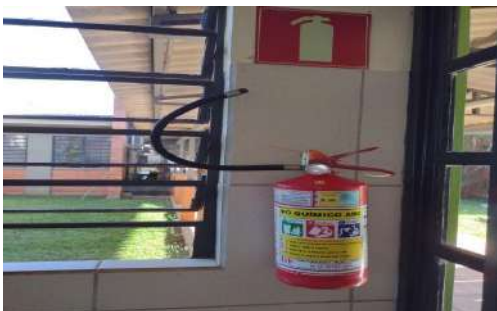
Figura 11. Prédio E – Cantina
