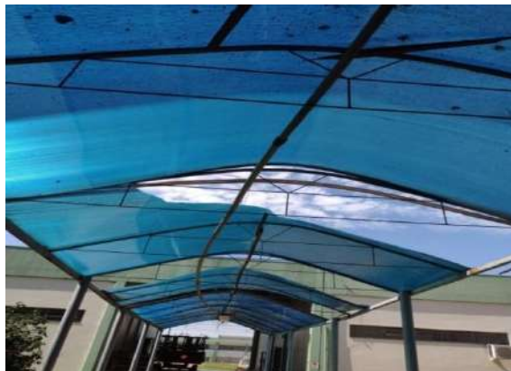
Figura 6. Passarela para o Lab. de Edificações
