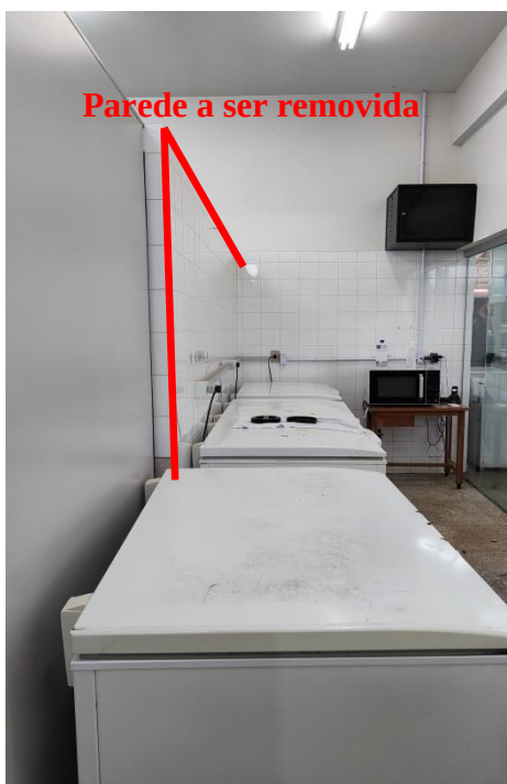
Figura 1 – Parede a ser removida
