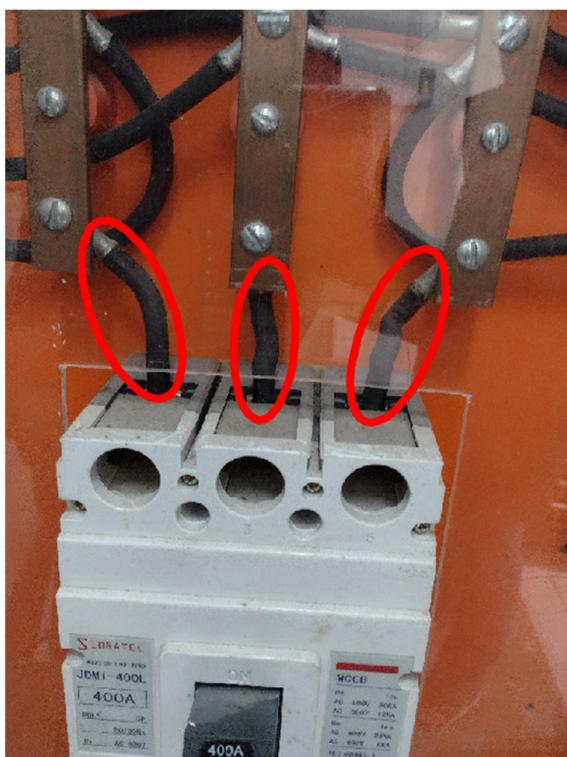
Figura 2: Trocar os cabos por barras extensoras de cobre de 450A
